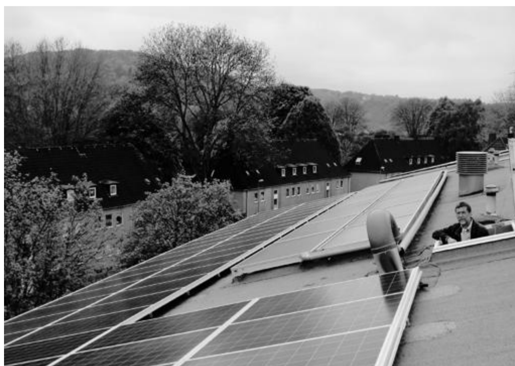
▲ Rolf Novy-Huy wirft einen Blick aus der Dachluke über die PV-Anlage
